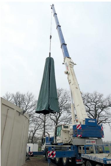
Der größte Teil der Dachlasten wird über den Hochpunkt und die Mittelstütze abgeleitet. Je größer der Hochpunktdurchmesser, umso geringer werden die Dachmembrane und die tragenden Untergurte im Anschlussbereich beansprucht.
