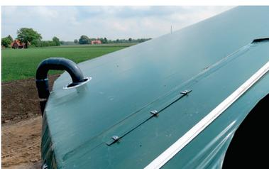
Bedienöffnungen, z. B. für Rührwerke, werden in verschiedenen Größen werksseitig eingebaut. Ein Regenabweiser verhindert die Wassersackbildung auf der Verschlusskappe. Der Seilverschluss sichert gegen Abheben und Abreißen bei Windeinwirkung.
