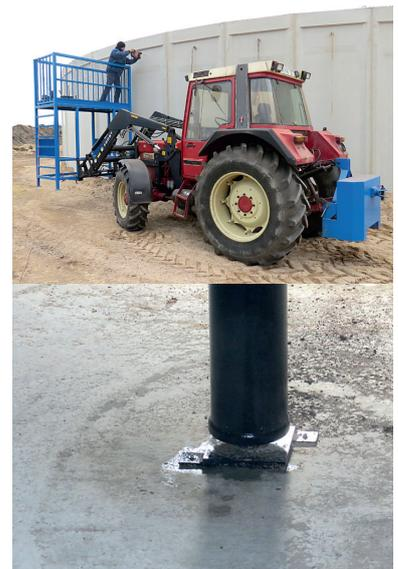
Nach dem Spannen des Daches werden die Rohrdurchführungen eingebaut – mit Doppelflanschen aus Hartkunststoff werden diese ober-/ unterseitig verschraubt.
