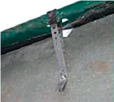
Das CENO-Hochsilodach wird am Behälterrand über ein Randrohr mit statisch dimensionierten Edelstahlbändern fixiert und über den Mittelpunkt der Pendelstütze nach oben hin gespannt. Somit erhält die Dachmembrane an jeder Stelle eine gleichbleibende Spannung. Ein einseitiges Verziehen ist nicht möglich!
