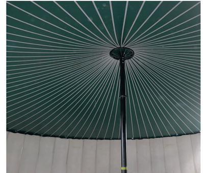
Für die richtige Dachspannung sind CENO-Fachleute zuständig – bei der Erstmontage wird entsprechend der Statik die Spannung aufgebracht. Ein nachspannen ist nicht notwendig!
