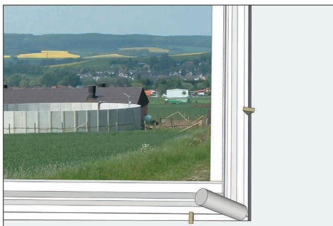
Rahmen mit Montageschaum an den Ecken befestigen. Holzkeile entfernen und rundherum ausschäumen. Überstehenden Schaum bündig abschneiden und anschließend dauerelastisch abdichten.
